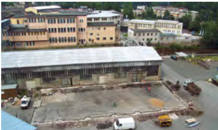
Stavba skladu u haly rozvláknování 15. 7. 2002
