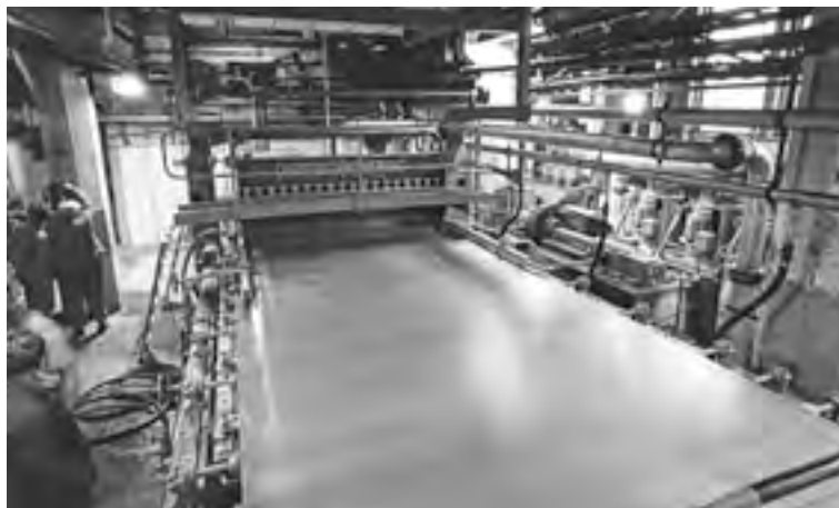
Rekonstrukce PS 4 r. 1974
