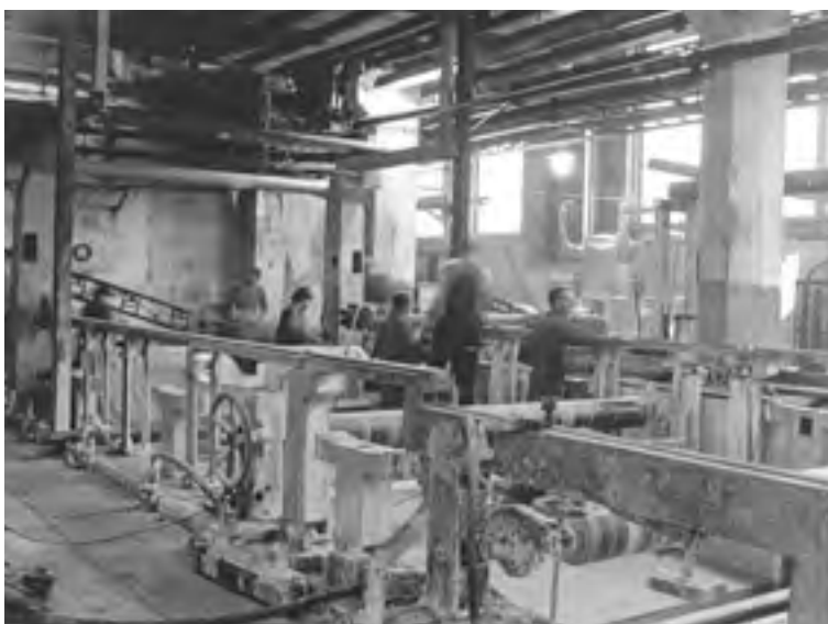
Rekonstrukce papírenského stroje PS 4 r. 1974
