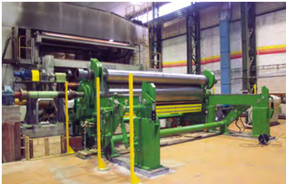
Rekonstrukce PS 6 r. 2004
