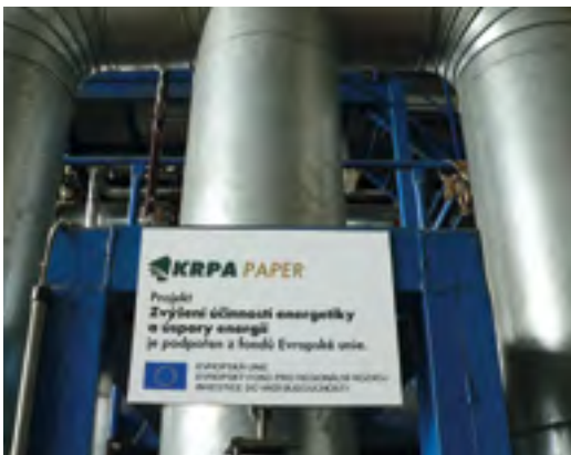
Rekonstrukce parokotle r. 2009
