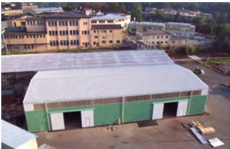
Stavba skladu u haly rozvláknování 27. 8. 2002
