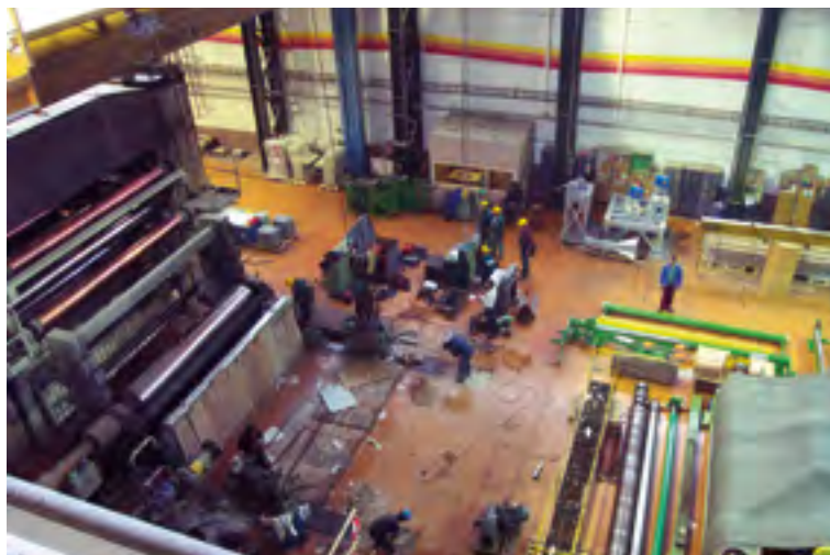
Rekonstrukce PS 6 – navíjení r. 2004
