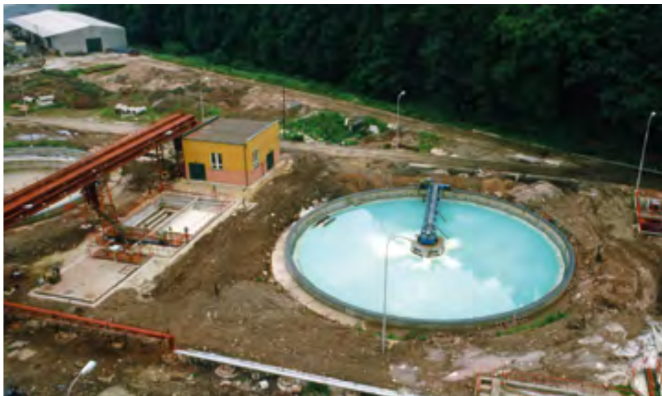
Zprovoznění nové čističky odpadních vod r. 1984
