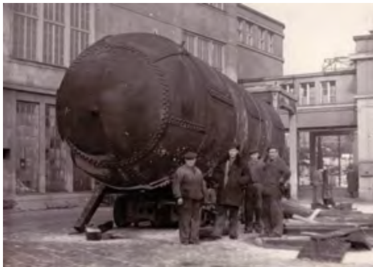
Stěhování kotle ze staré kotelny celulóžky r. 1957
