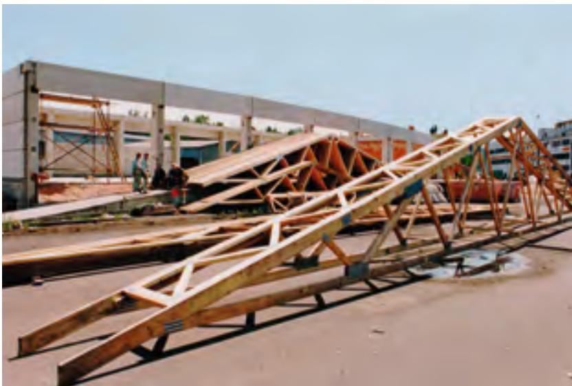
Výstavba centrálního skladu nákupu r. 1995
