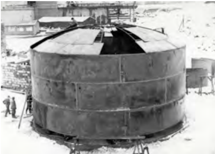
Stavba mazutového přítápění r. 1973
