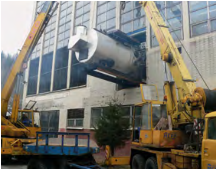
Rekonstrukce kotle K3 a K4 r. 2009
